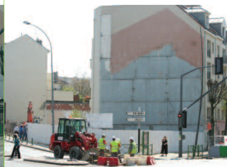
La fin du chantier de démolition.
