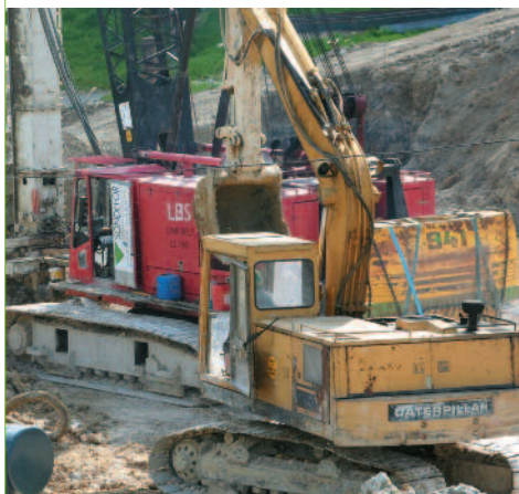
Les travaux en date du 27 avril.
