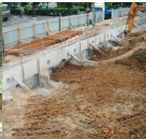
Les travaux fin mai.
