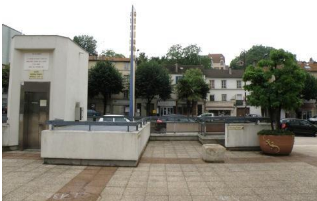
Des entrées de parking dévalorisant la place
