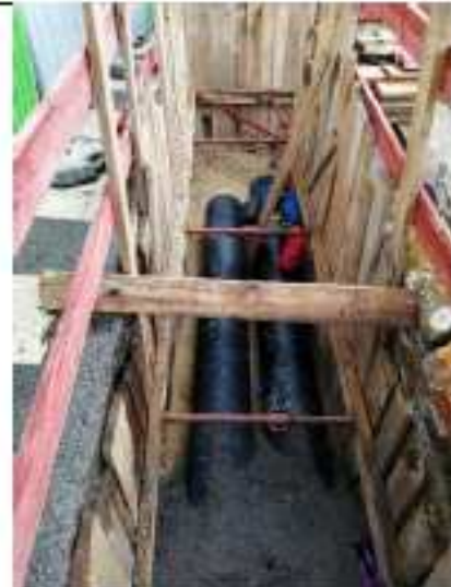
Installation des réseaux dans les tranchées
