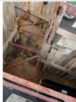
Ouverture de la tranchée
