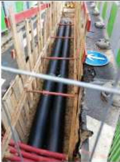
Installation des réseaux dans les tranchées
