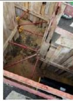
Ouverture de la tranchée
