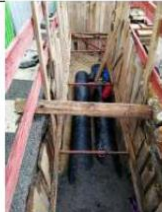
Installation des réseaux dans les tranchées
