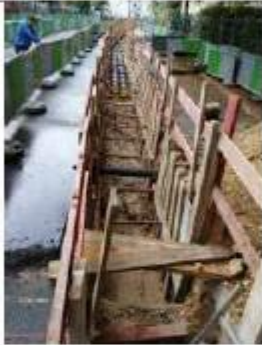
Ouverture de la tranchée
