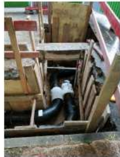
Installation des réseaux dans les tranchées
