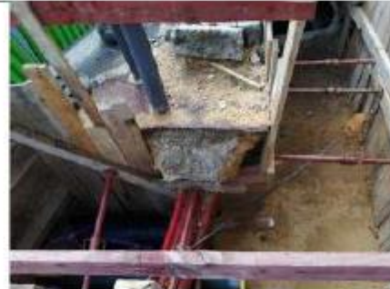
Tranchées de la 1 ère chambre de vanne – à relier au tuyau sur la voie du Général de Gaulle
