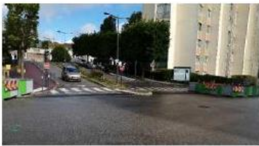
Croisement Général de Gaulle – tuyau soudé et chaussée refaite pour le passage des bus
