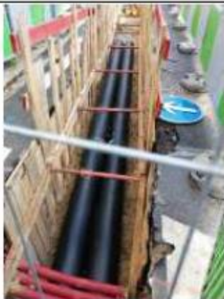
Installation des réseaux dans les tranchées
