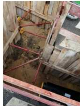
Ouverture de la tranchée
