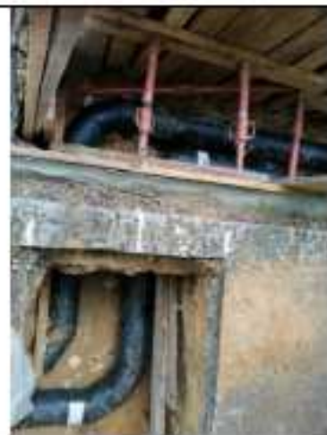
Installation des réseaux dans les tranchées
