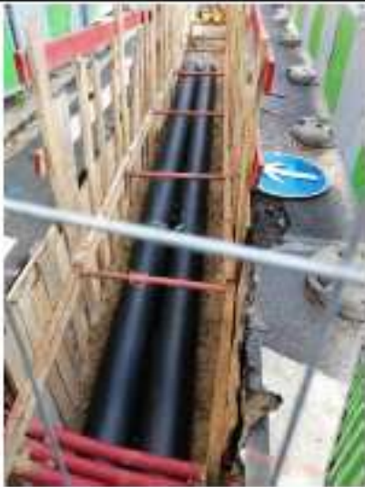
Installation des réseaux dans les tranchées
