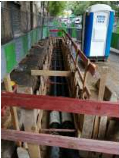
Installation des réseaux dans les tranchées
