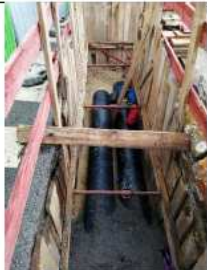
Installation des réseaux dans les tranchées
