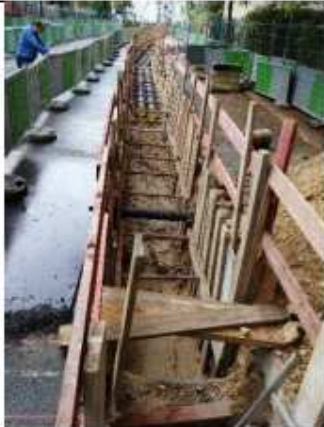
Ouverture de la tranchée
