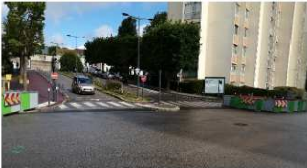
Croisement Général de Gaulle – tuyau soudé et chaussée refaite pour le passage des bus
